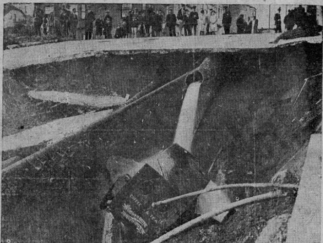
La explosión de un tanque de gas causo los des trozos que pueden apreciarse en esta fotografía, tomada en el centro de San Francisco, California. Una cuadra entera de pavimento se convirtió en un precipicio en que cayó un camión, resultando heridas seis personas.
